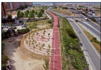
Panorámica de la II Fase del AVC a su paso por el distrito de Hortaleza
