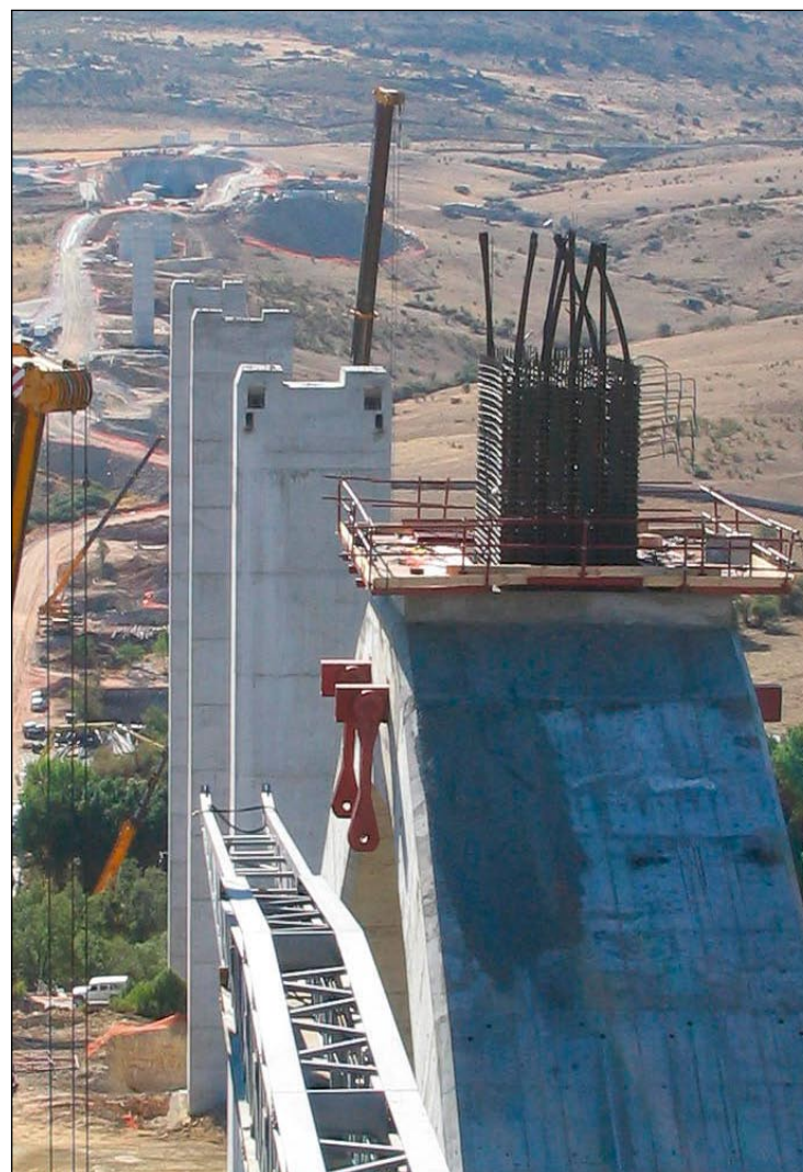
Viaducto Arroyo del Valle
