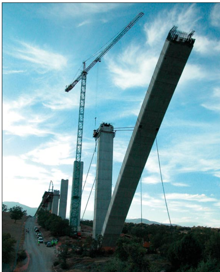
Viaducto Arroyo del Valle
